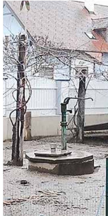
Brunnenabdeckung am Stand der Technik (l.). So wie im rechten Bild bitte nicht: Dieser Brunnen auf einem Kleintierauslauf ist von Verunreinigungsquellen umzingelt. Zudem ist der Schachtdeckel nicht dicht ABT. 14, MUSCH
