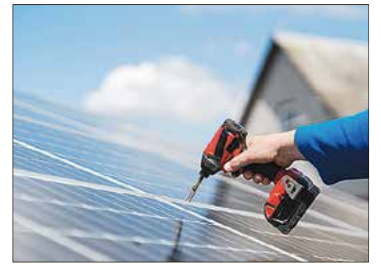
Anlagenteile und Montage steuerfrei
