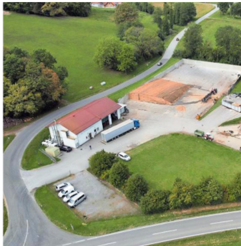
21 sterische Biogasanlagen (im Bild die Anlage in Bad Blumau)
